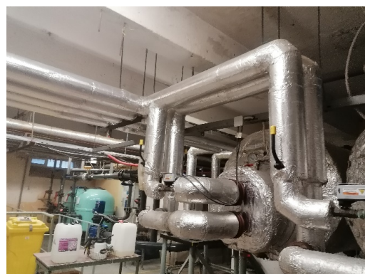
Napojení ohřivačů na horkovod PN25.
