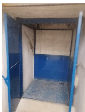
Výťahová plošina pro přepravu materiálu o půdorysném rozměru 1,1 x 1,3 m
