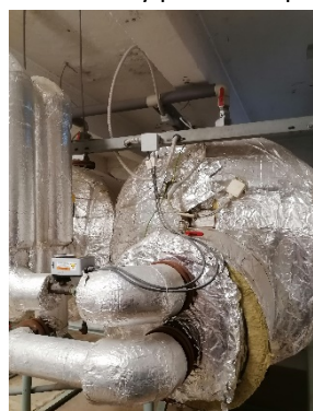
Připojení výměníku osazené kulovým kohoutem se servopohonem
